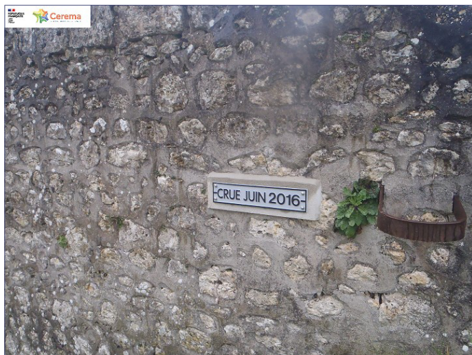
Illustration 4 : repère de la crue de 2016 du Beuvron, posé sur le pont de la RD 154 par la mairie de Tour-en-Sologne
