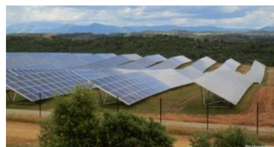
Photographie 1 : Exemple d'installation photovoltaïque au sol
